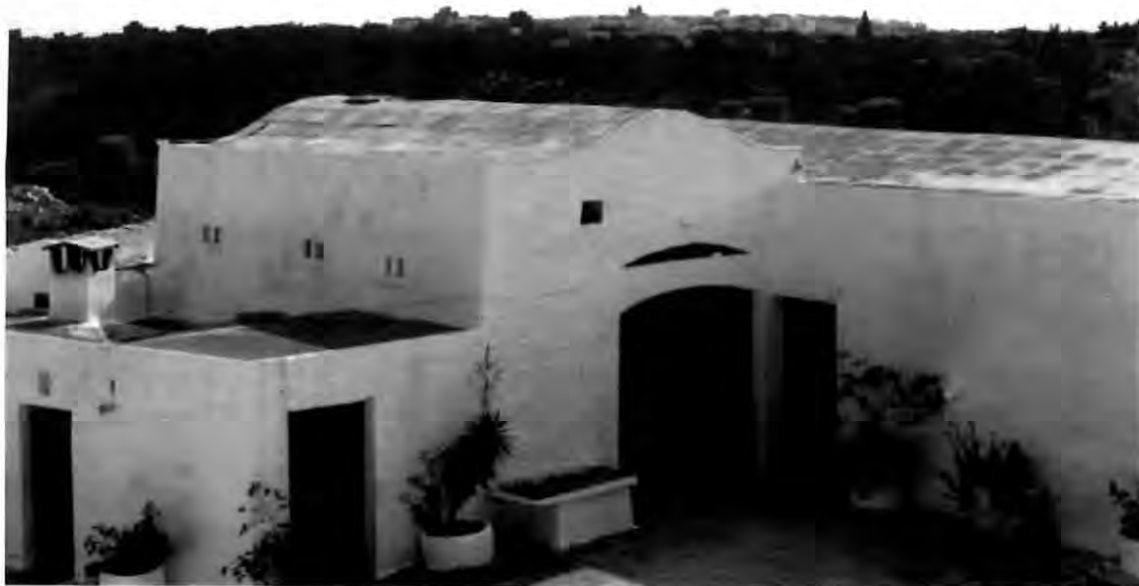
Area dei servizi nella corte di masseria Fragniti. Sullo sfondo, panorama di Ceglie Messapica.
