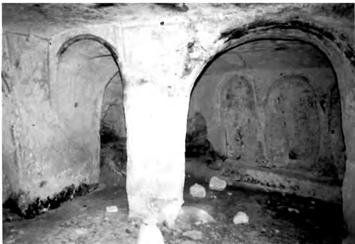
Interno di Santa Maria di Costantinopoli. La realizzazione delle cripte in rupe era favorita dalla presenza di banchi rocciosi poco tenaci. (foto Anna Lia Netti)
