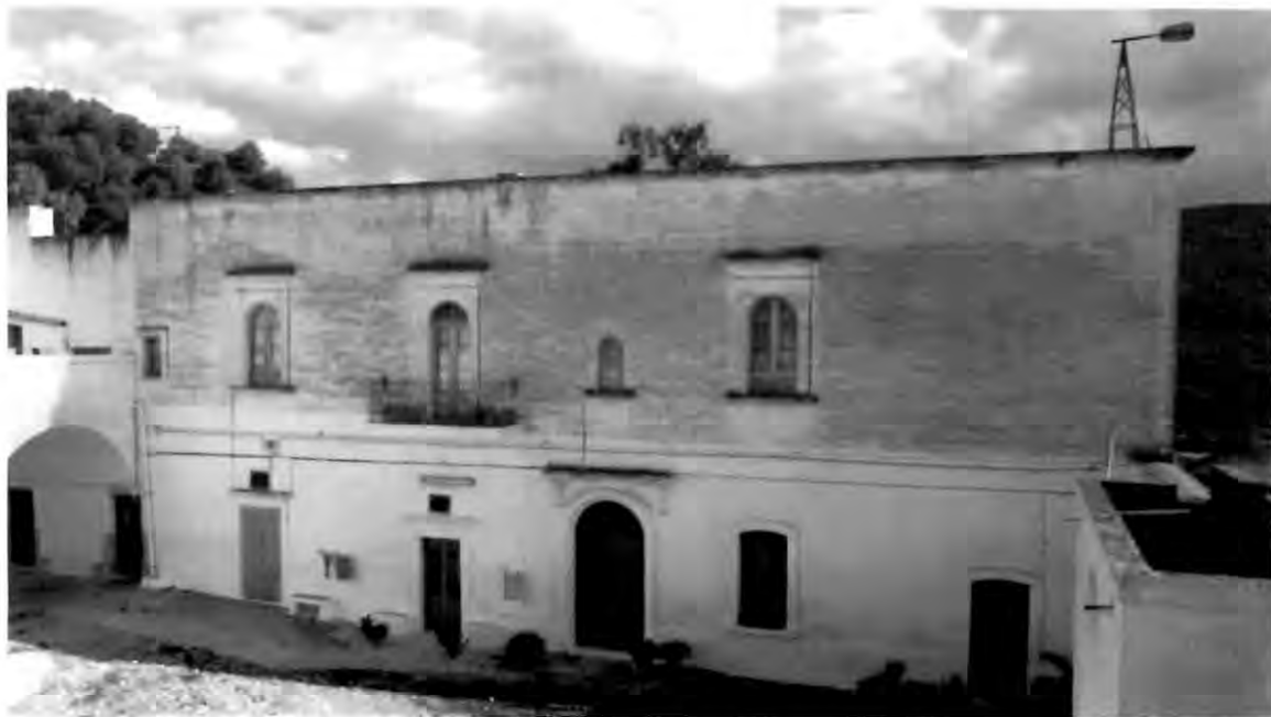
Luigi Perrone completò nel primo piano la casa padronale di masseria Lupoli.
