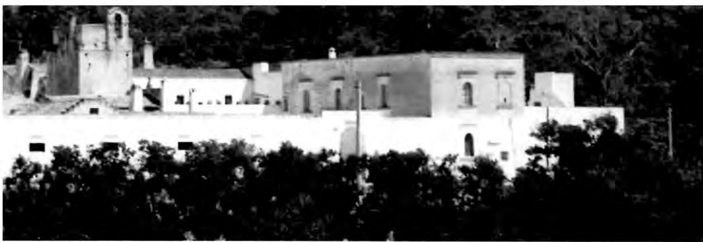
Corpo di fabbrica di masseria Lupoli.
